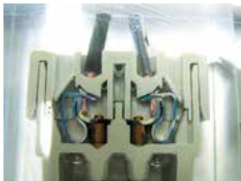
图 VI-5: 使用已剥好的绞线进行接线
